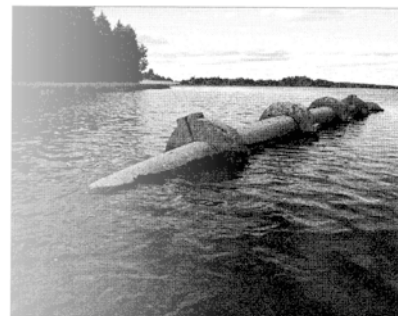
Putki kellumassa Pitkäjärven (Pekka Puomio)
