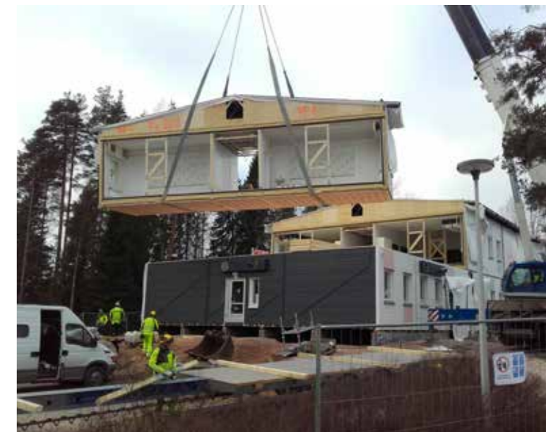
Viimeisiä moduuleita nostetaan paikoilleen ensimmäiseen siirtotilaan 22.11.2018.
