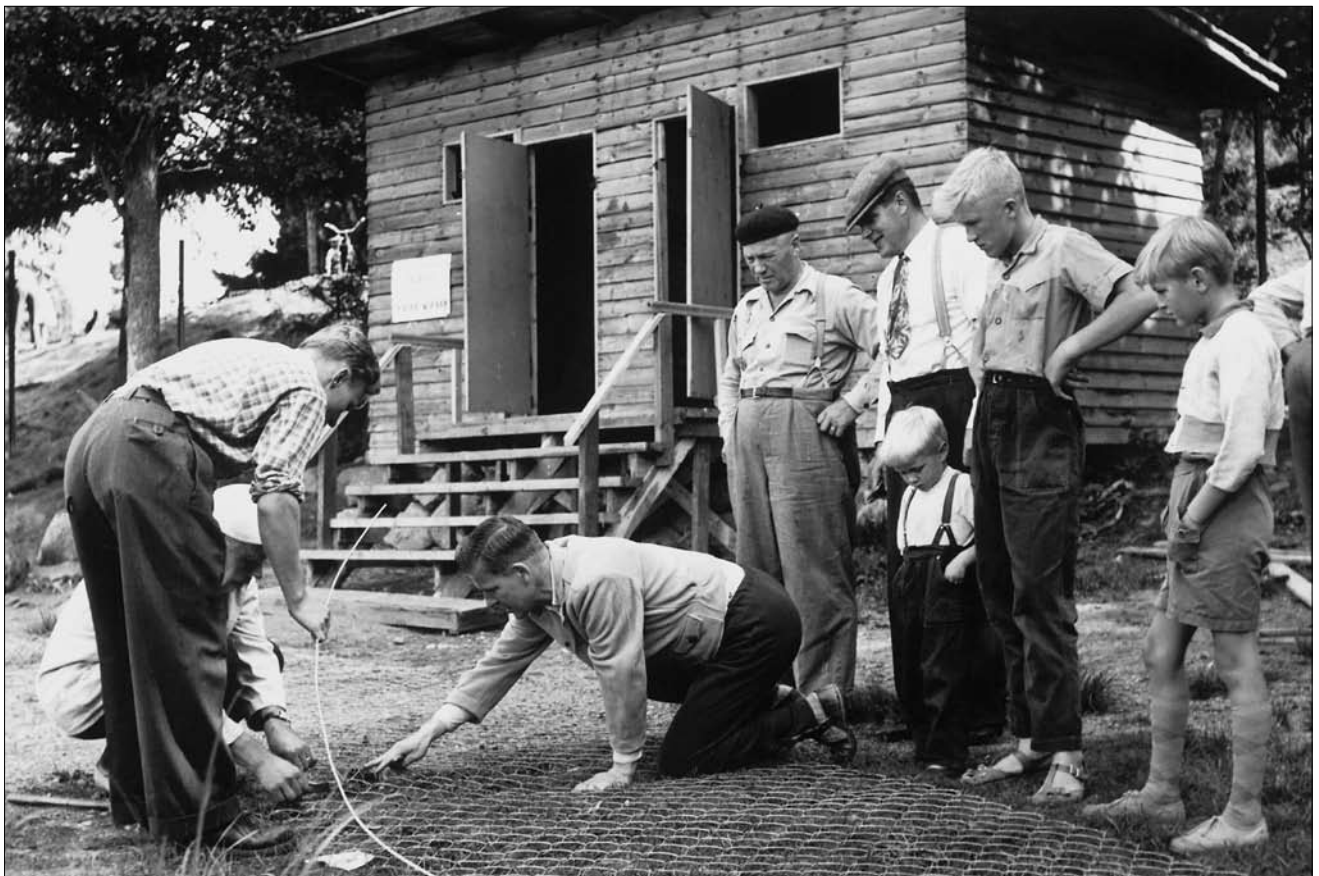
Uimarannan aita rakennetaan. Portin pylväät ovat vieläkin pystyssä.
